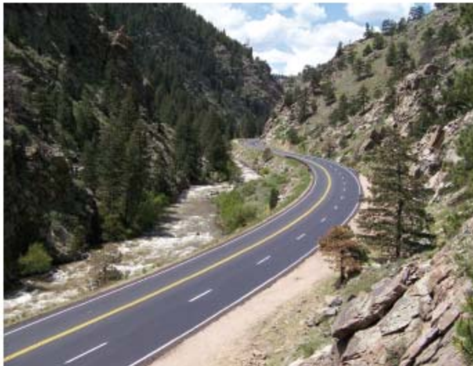
Carretera US 6 Clear Creek Canyon: trabajos para evitar la caída de la roca.
